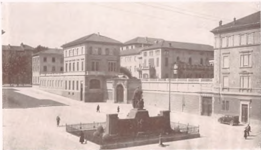
La sede del Consiglio generalizio delle Figlie di Maria Ausiliatrice in Torino.
