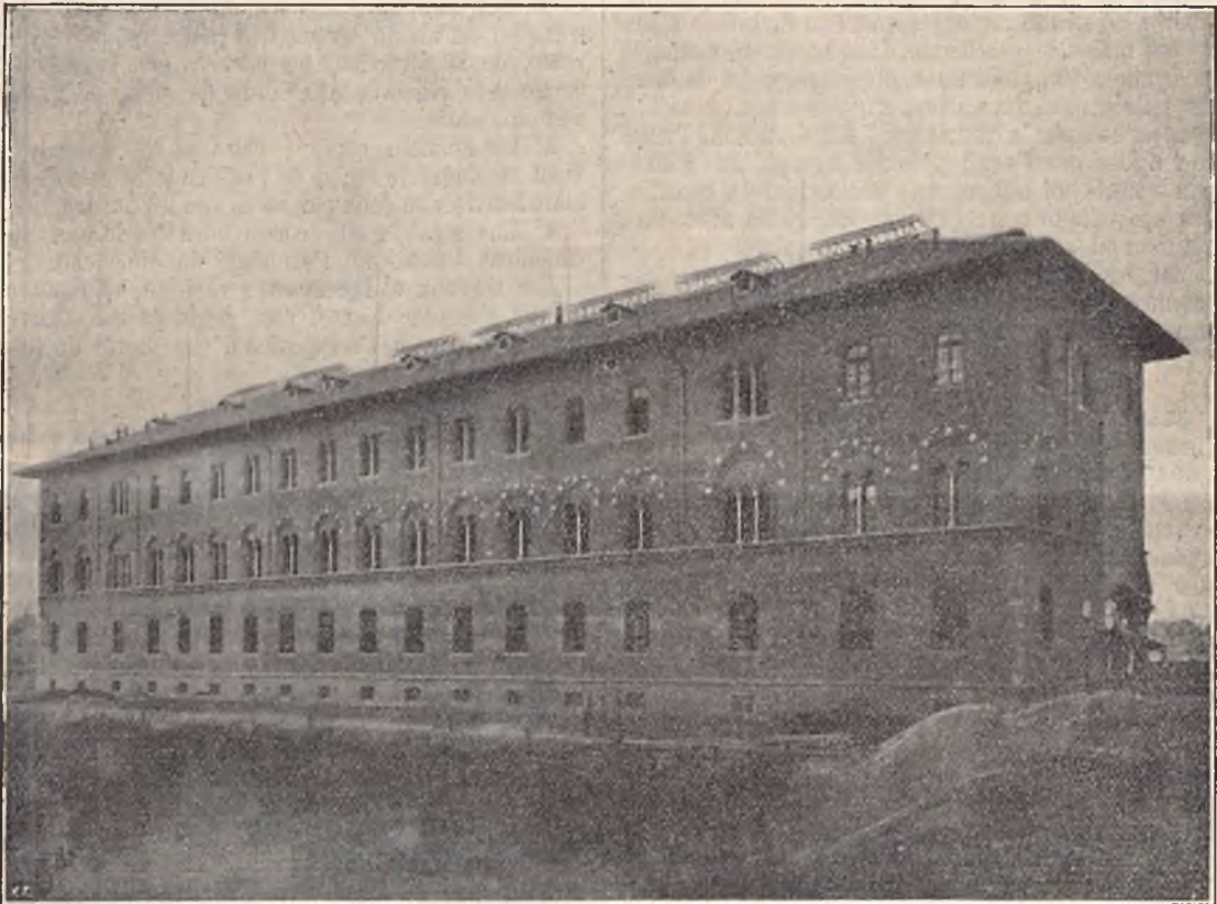
Milan — Façade du corps de bâtiment inauguré le 15 mai 1897
