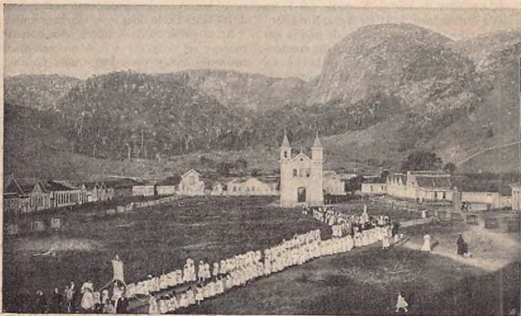
CARATINGA (Brésil-État de Minas Geraes) — Procession de clôture de la Mission, p. 103.
